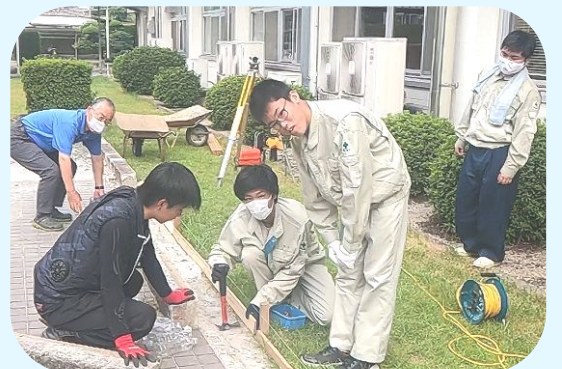
中庭を修繕する土木研究部
