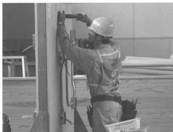
ものづくりコンテスト（電気工事）
