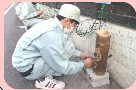
電気情報科の笠工テクノ工房が富岡保育園にイルミネーションを設置
